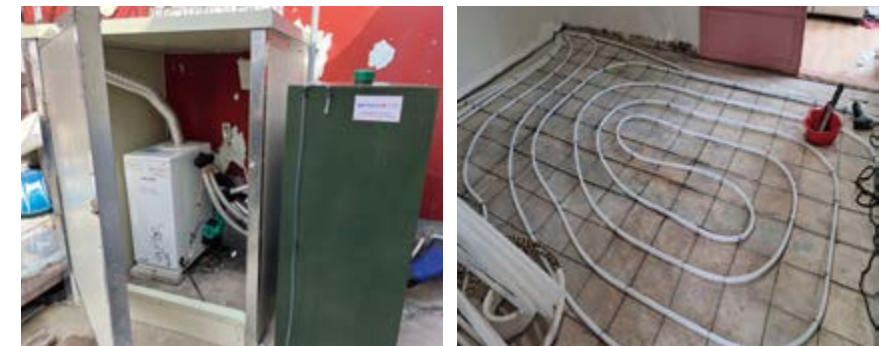
장애가정 보일러 시공
